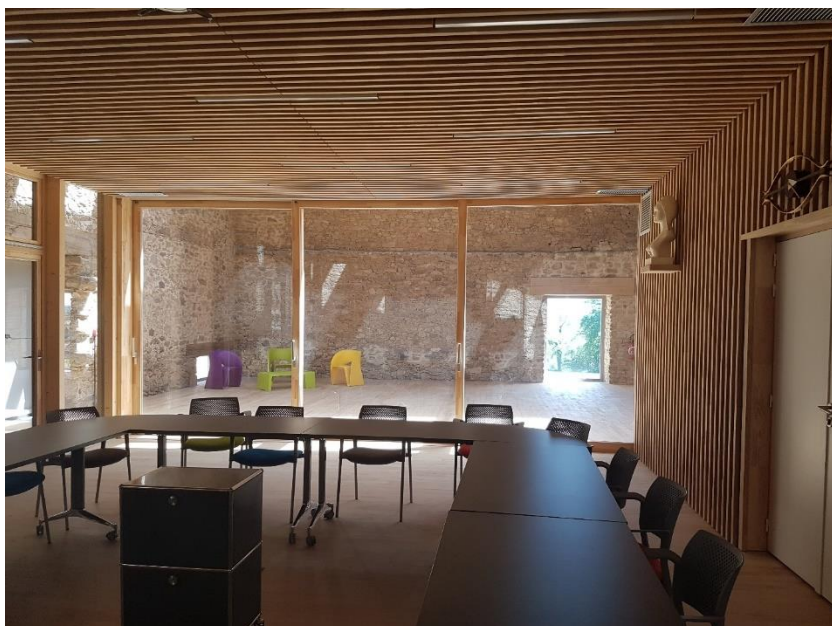
Dans la salle du conseil, le châtaignier est omniprésent : parquet, murs et plafonds.
