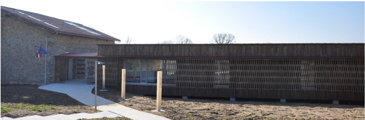
En façade extérieure, bardage et résille en châtaignier pré grisé, afin d'éviter les différences de couleur dues au vieillissement différencié selon les expositions au climat.
