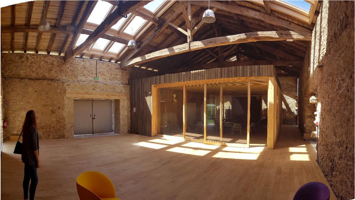
La salle du conseil dans l'ancienne grange : parquet et bardage en châtaignier, peuplier en sous face de toiture, plafonds et murs en châtaignier dans la salle du conseil. Présence de la charpente d'origine en chêne.
