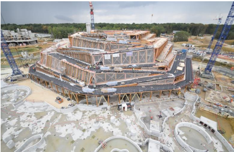
Illustration 8 : Vue aérienne du chantier de l'Aqualagon, septembre 2016 © Chantiers Modernes Construction
