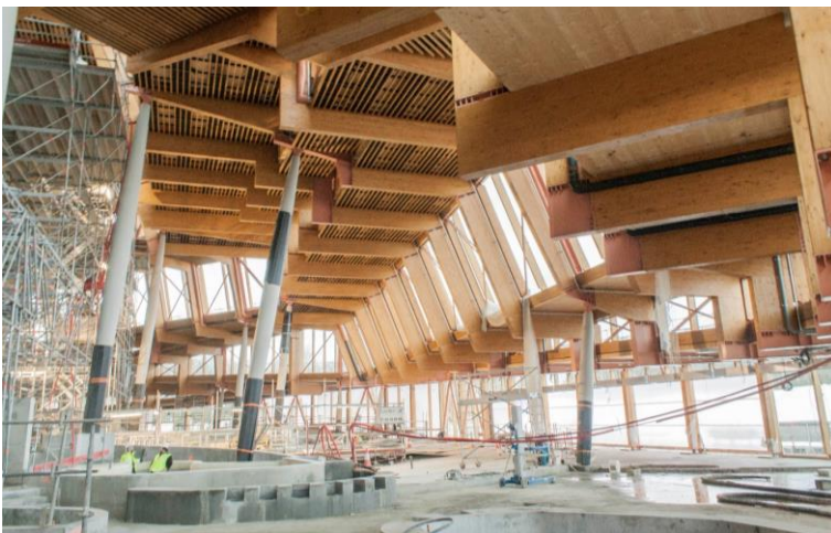
Illustration 9 : Aqualagon, vue intérieure de la structure, mars 2017 © Jacques Ferrier Architecture
